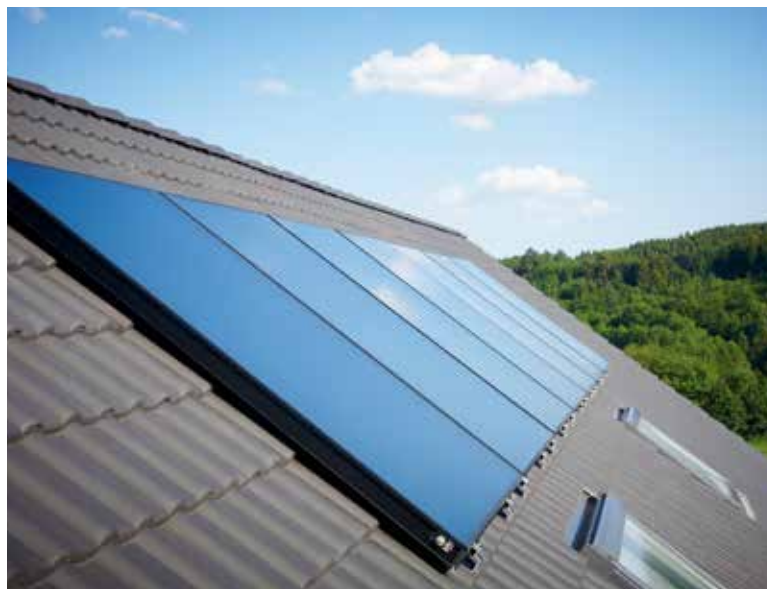
Pločasti kolektori montirani na kosi krov
